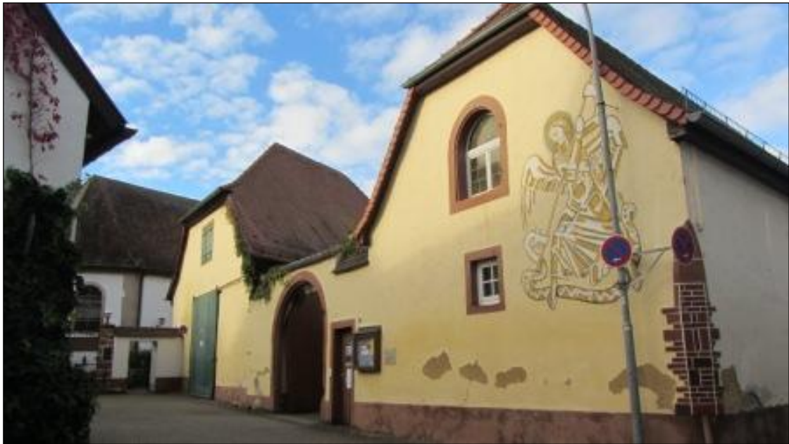
Abbildung: Anwesen Kirchgasse 9/11 Quelle: Eigene Fotografie
